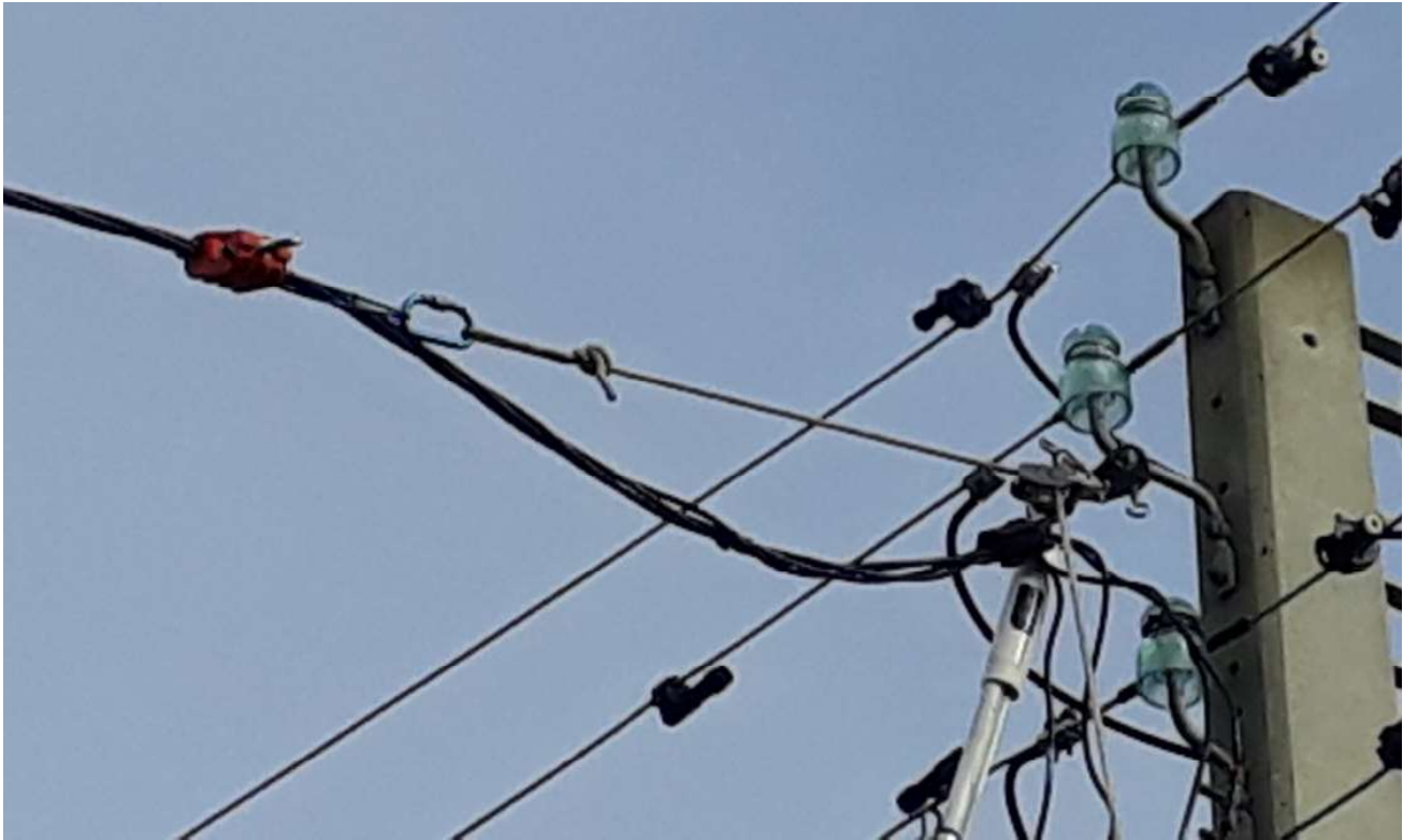
Immobilisation d'un câble isolé torsadé de branchement
