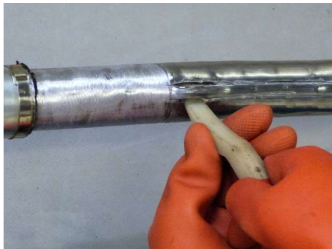
Retrait de la gaine de plomb à l'aide du levier isolant (FT BT 505)
