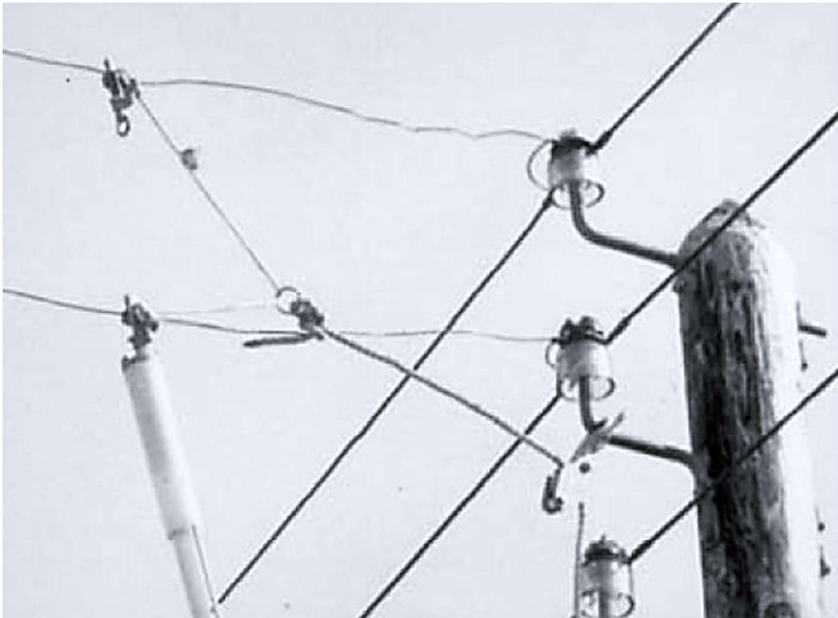
Mise en attente de deux conducteurs aériens
