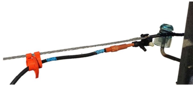
Deuxième utilisation : Maintien d'une connectique pour réseau aérien
