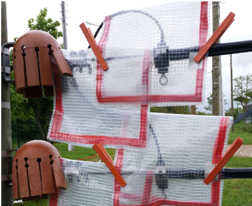
Habillage de conducteurs et d'isolateur d'arrêt
