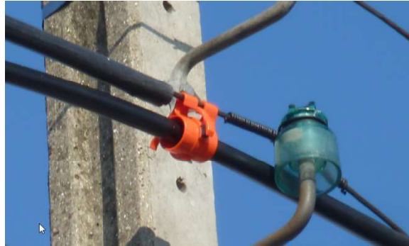
Première utilisation : Maintien d'une gaine profilé isolant
